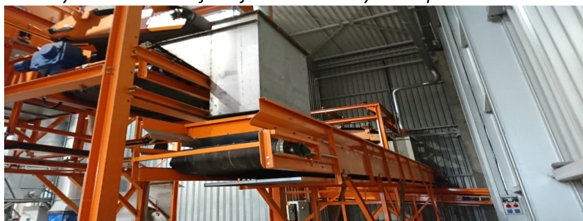
Rysunek 5 Odbiór frakcji metali żelaznych z separatorów 4-2 oraz 4-5
